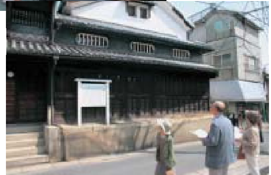
江戸時代に繁盛した鞆の典型的な商家の建造物。 土蔵の基礎の長い石注目。
